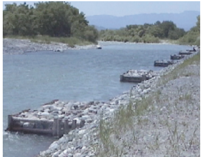
■水制護岸工
