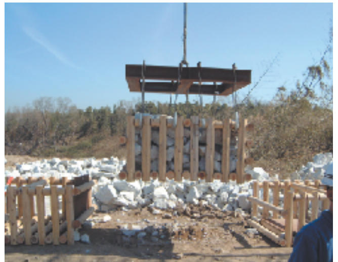
■中詰後吊上施工
