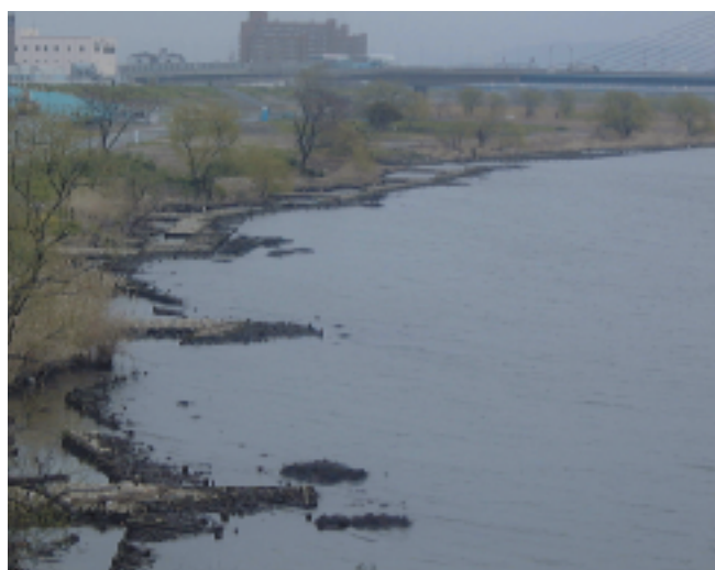
■ 緩傾斜護岸工
