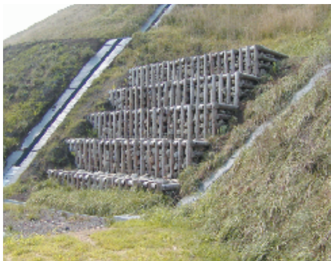
■ 土留め工（階段積）
